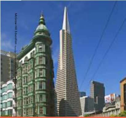
تغير لون هذا البناء إلى اللون الأخضر نتيجة تغير كيميائي. ▼
